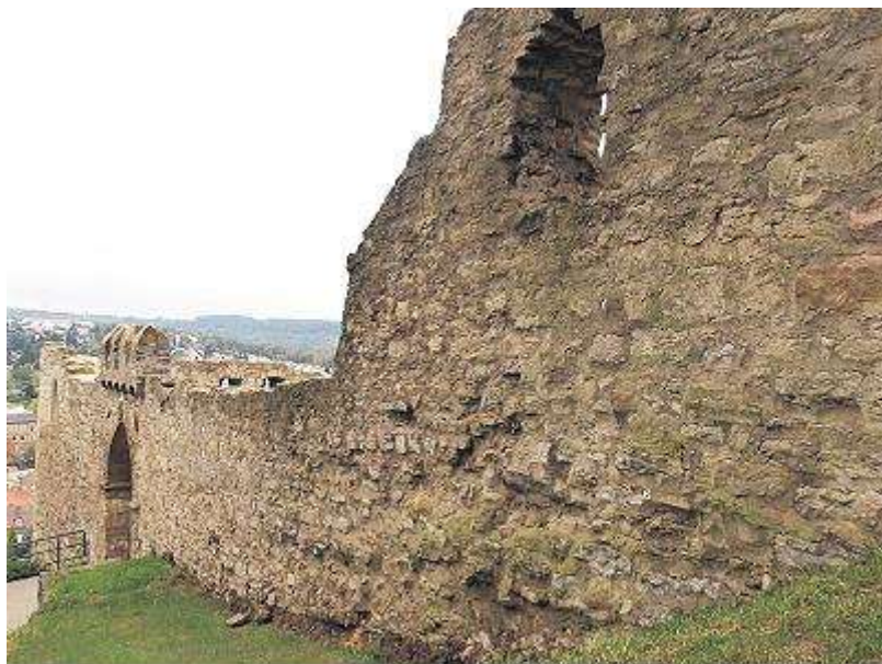
An der Südostecke der Burg wartet ein Keller auf seine Freilegung.
